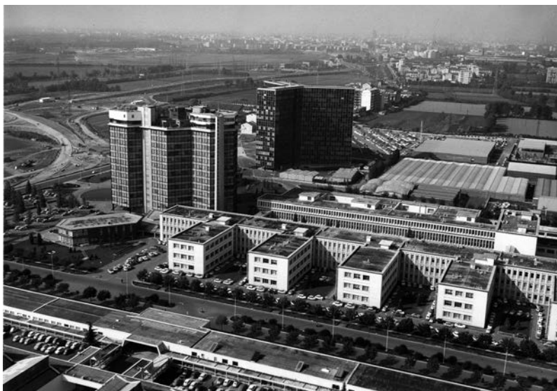
San Donato Milanese, panoramica Palazzi Uffici ENI. (foto Archivio Storico Eni Roma)
