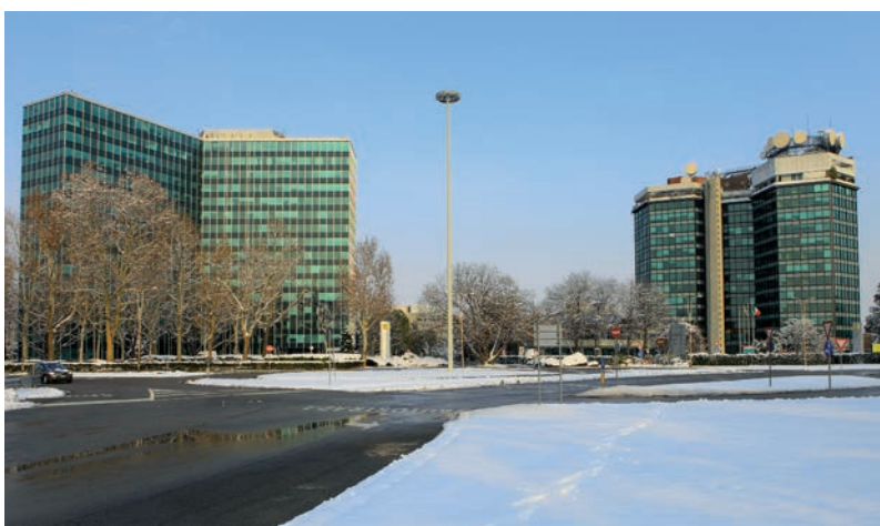
San Donato Milanese, Primo e Secondo Palazzo Uffici ENI. (foto Archivio Storico Eni Roma)
